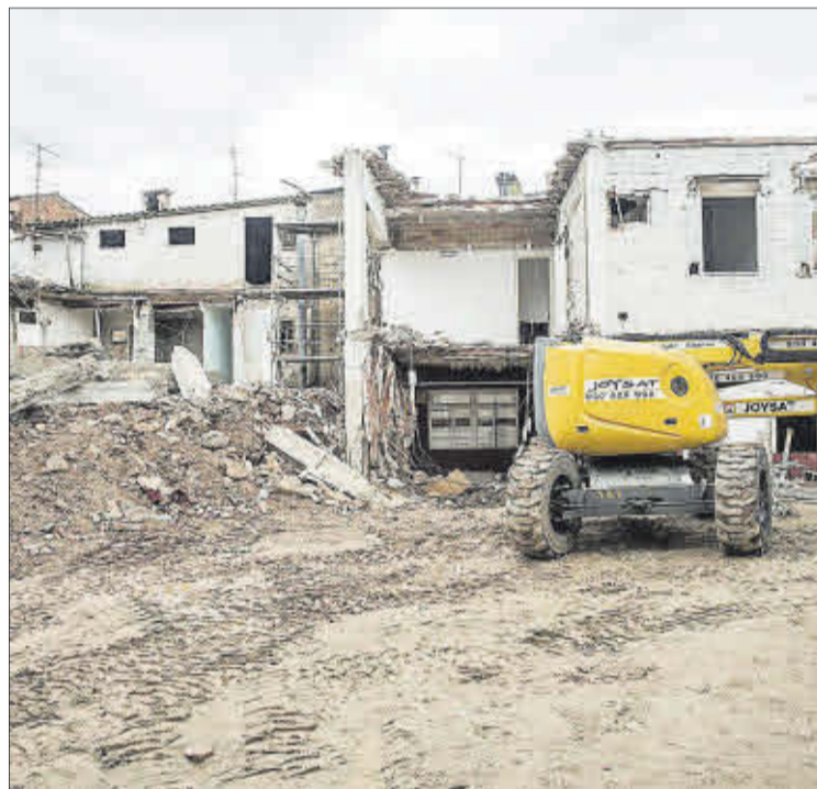
Treballs d'enderroc que es van fer a la finca de Cal Pau
