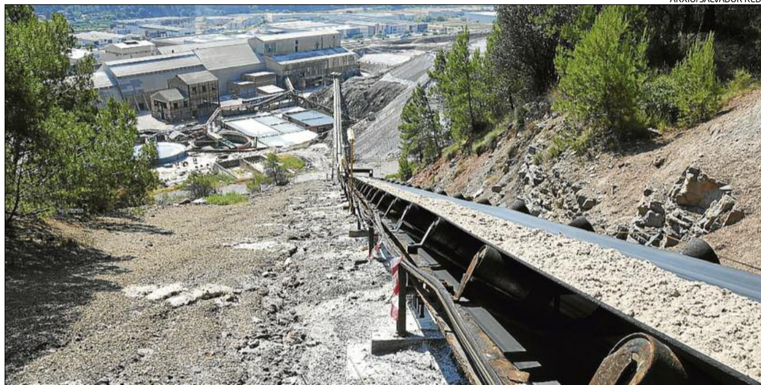
Cinta transportadora del material que surt de la planta de Sallent cap al runam del Cogulló
