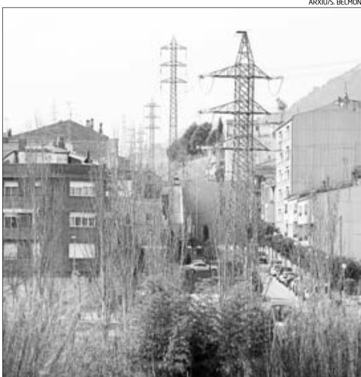
Torres de la línia d'alta tensió al bell mig del carrer Ample de Sant Joan
