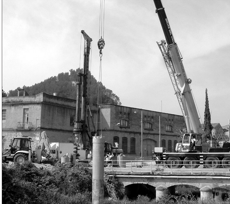
Obres al pont de la Farinera, les últimes que han començat
