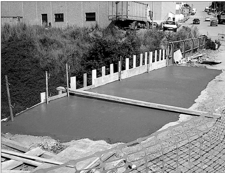
Una part del pont va cedir, i ara se n'està acabant la reparació
