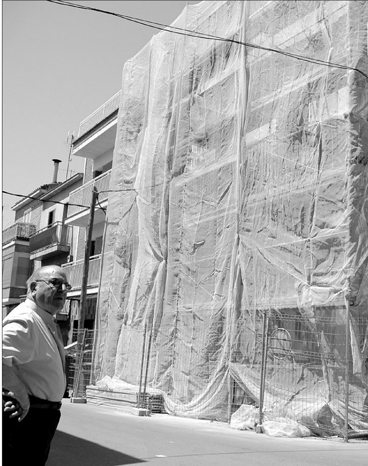
El vell edifici ja s'ha començat a enderrocar per fer-hi el nou equipament
